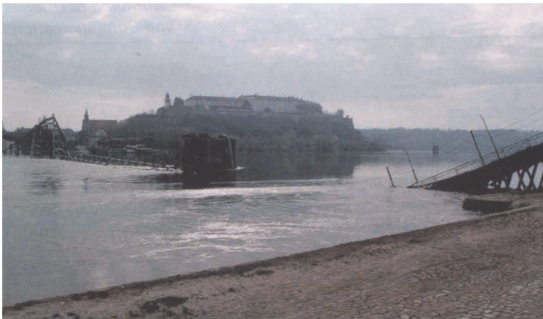
Photo n° 2: Pont Varadinski, Novi Sad
