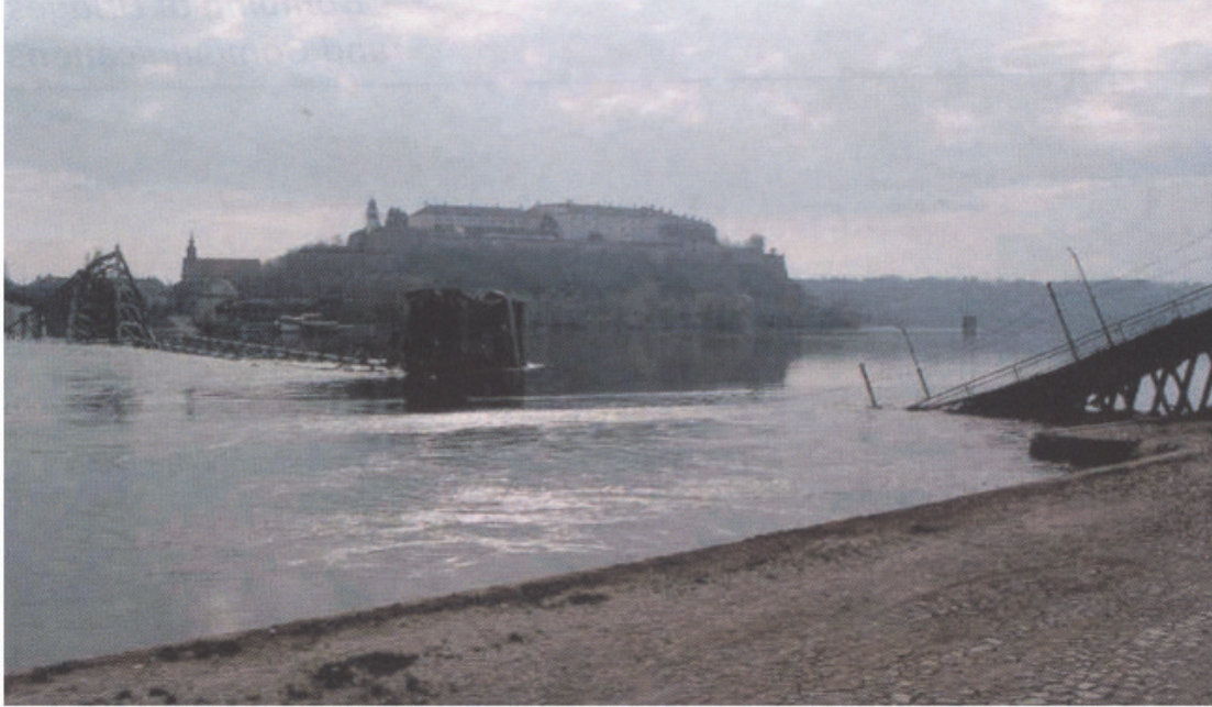
Photo n° 2: Pont Varadinski, Novi Sad
