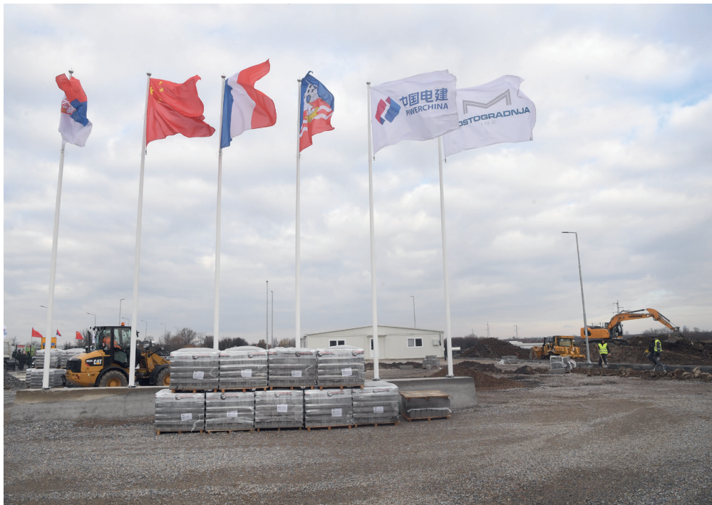
贝尔格莱德地铁马基仕车辆段建设的准备工作,这是塞尔维亚最大的基础设施项目之一
