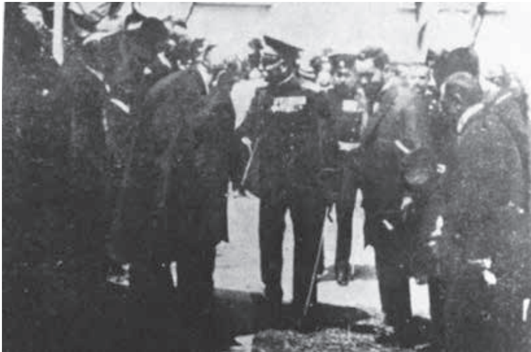
Полагање камена темељца београдске синагоге Бет Јисраел . Фотографије: Јеврејски историјски музеј у Београду
